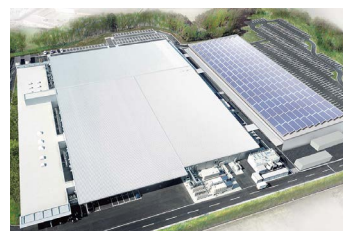
太陽光パネル
