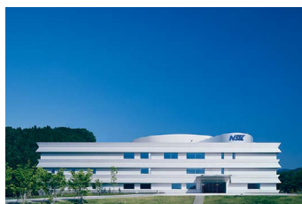
本社棟(RD1棟)
