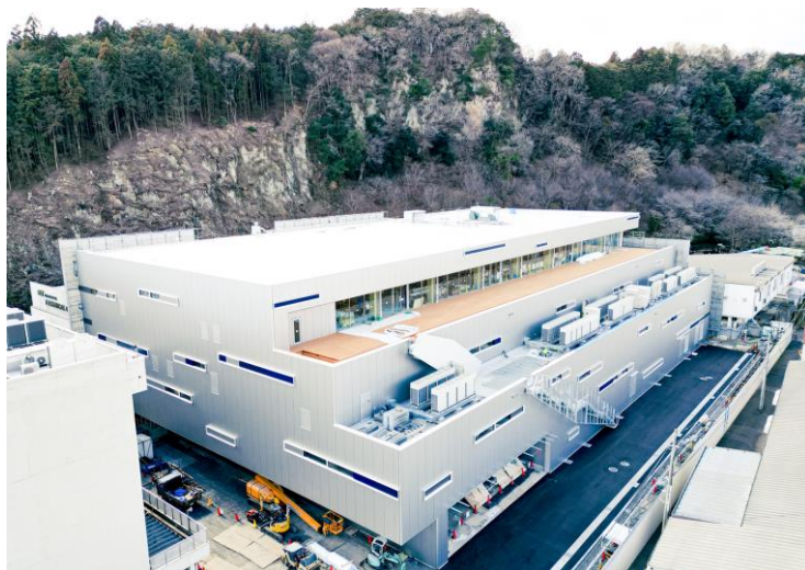
▲ 2024年2月 建設中の新工場「M1」
