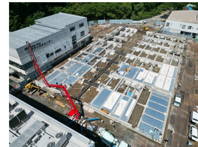
▲ 新工場「M1」の現在の様子。第1期工事区間の基礎工事が進む
