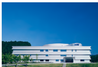
本社棟(RD1棟)
