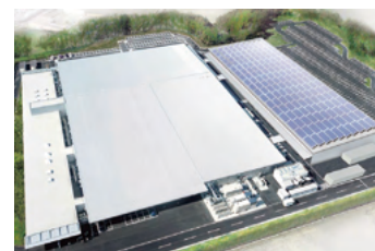
太陽光パネル
