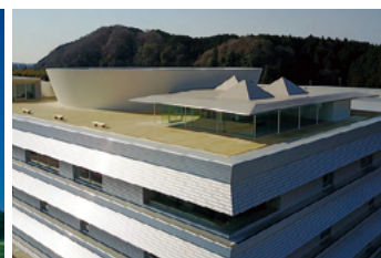
建屋外観(Σパネル:環境制御パネル)
