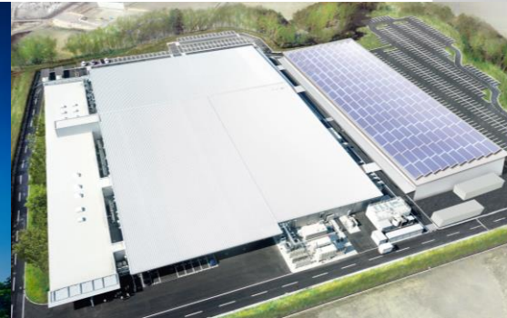
部品加工工場「A1」「A1+(建設中)」
