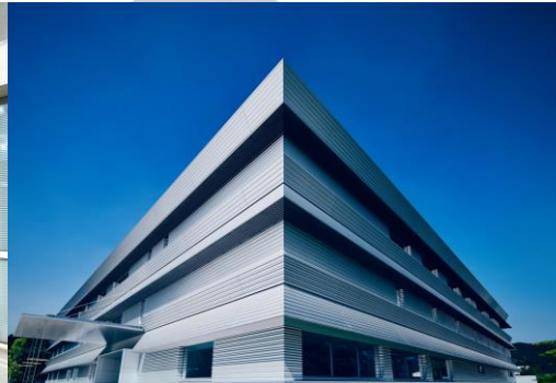
本社R&Dセンター「RD1」
