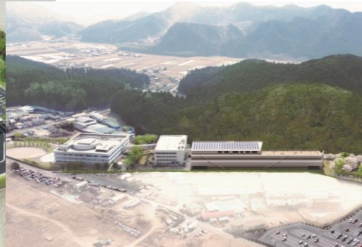
組立工場「M1(建設中)」
