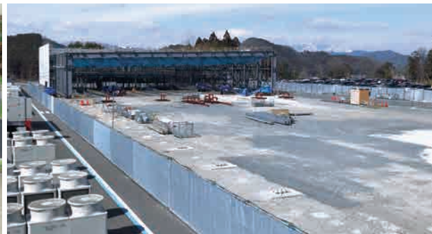
▲ A1+建設現場
