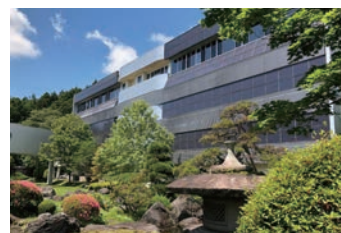
太陽光パネル
